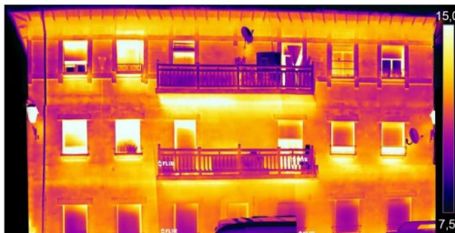
Fotomontaje con varias termografías del edificio sin reformar
